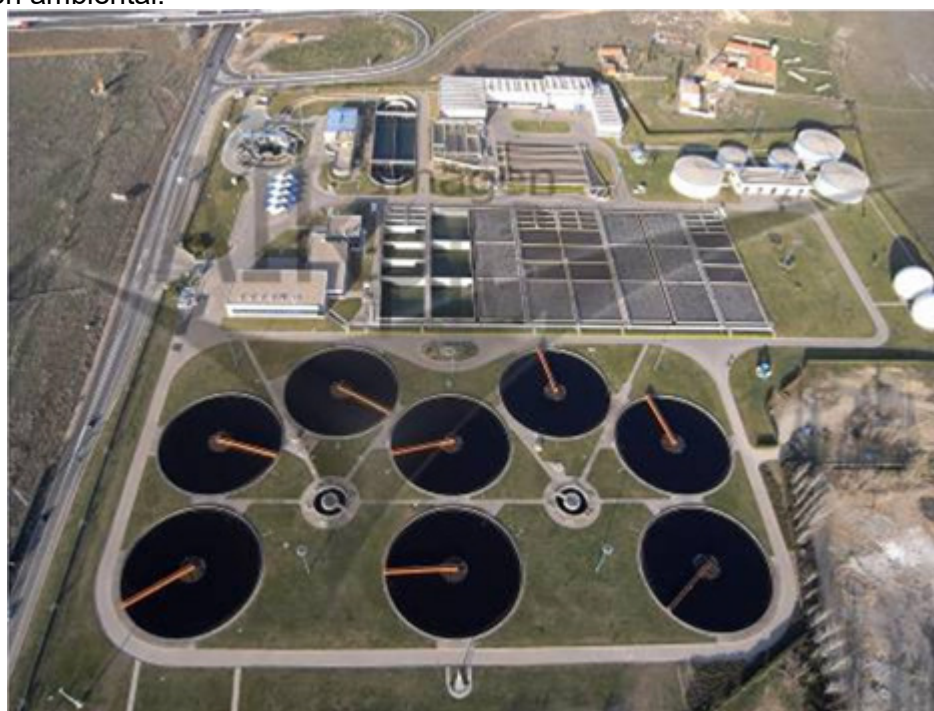
Figura 8 Detalle planta EDAR Valladolid.
