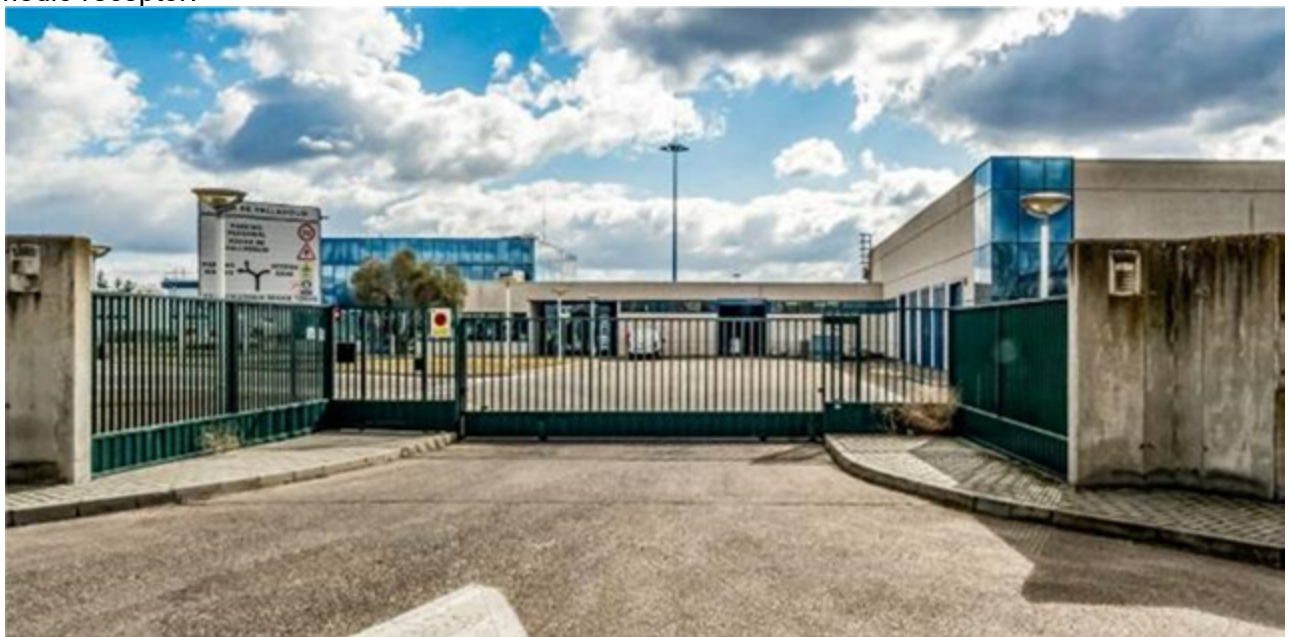
Figura 6 Entrada a la EDAR de Valladolid.
