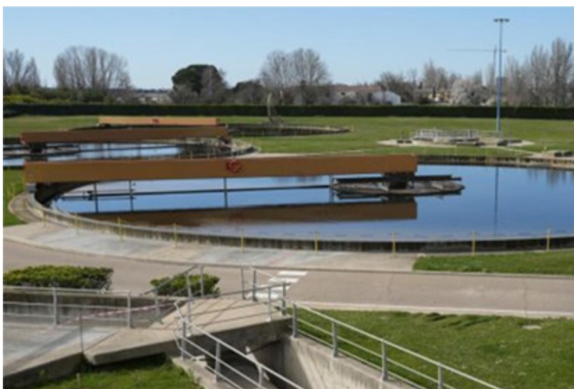
Figura 11 Decantación secundaria.
